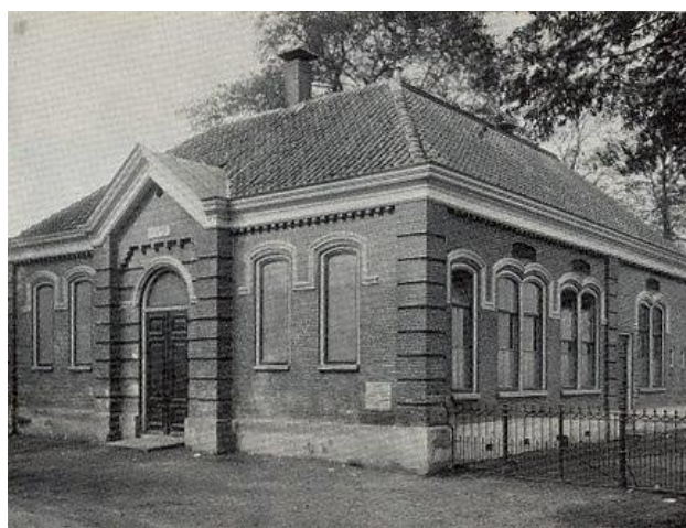
Op de fundamenten van dit schoolgebouw is later het woonblok Rijkstraatweg nrs. 118-128 gerealiseerd t.o. De Kleine Kerk.
