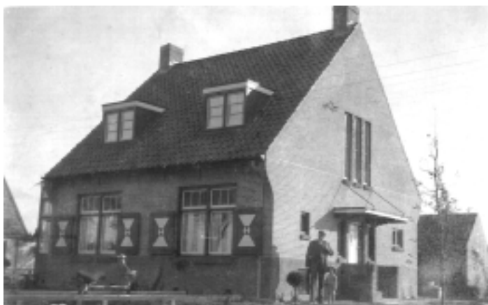
Het huis rond 1923. Op de foto staan Cornelis Stapel en zijn zoontje Gerrit Fokke. Let op het luikje achter Cornelis Stapel t.b.v. het inpandig "húske". Achter het huis staat een stenen berging, die in 1990 is vervangen door een houten variant. Tussen de berging en het huis lag een waterput, vanuit de keuken te bereikbaar middels een waterpomp. Links van het huis is de toenmalige erker zichtbaar. Voor het huis loopt nog een sloot, getuige de brug.
