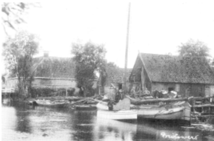
De âlde helling fan Kromwâl. Neist de helling it brêgewachtershûske, dan wenhuzen en in bakkerij.
